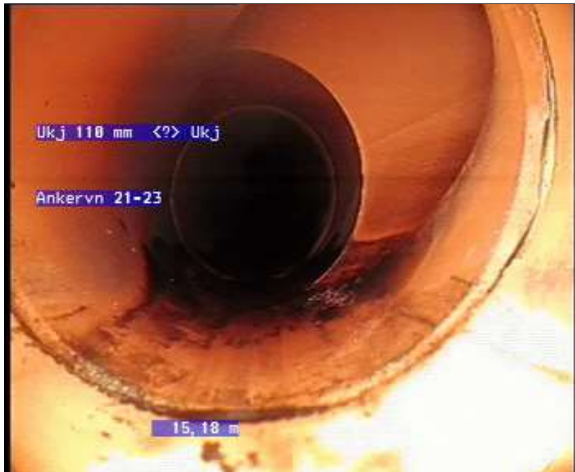
Foto: 5_1_5_11112014_051019_A.jpg 15,1m, Tilkopling Prefabrikkert grenrør. fra 12 til 06 Kl.
