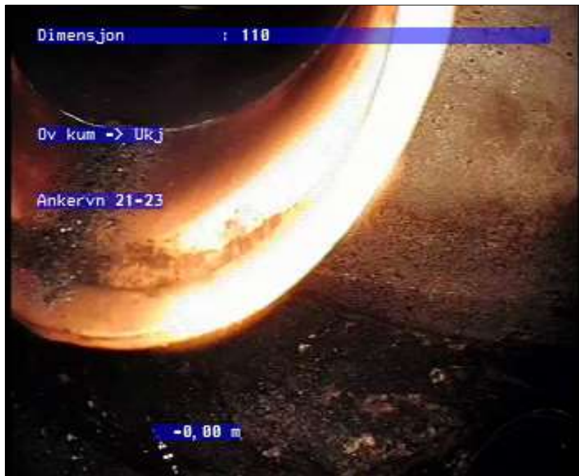
Foto: 4_1_1_11112014_043536_A.jpg 0m, Start inspeksjon -
