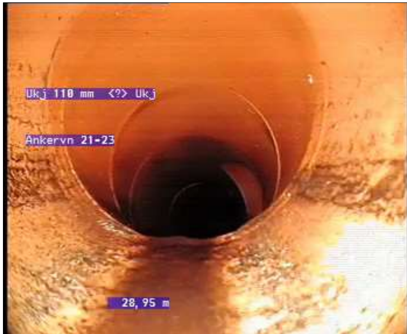
Foto: 5_1_11_11112014_051437_A.jpg 28,9m, Retningsendring 06 Kl., Prefabrikkert bend, Ned
