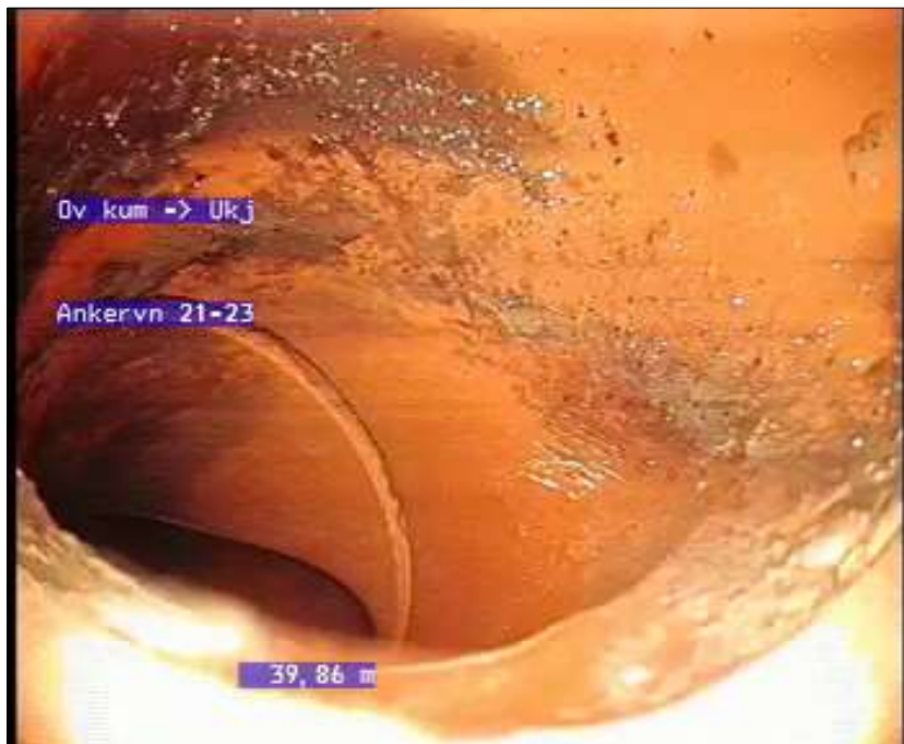
Foto: 4_1_11_11112014_044407_A.jpg 39,8m, Retningsendring 08 Kl., Prefabrikkert bend, Ned, venstre
