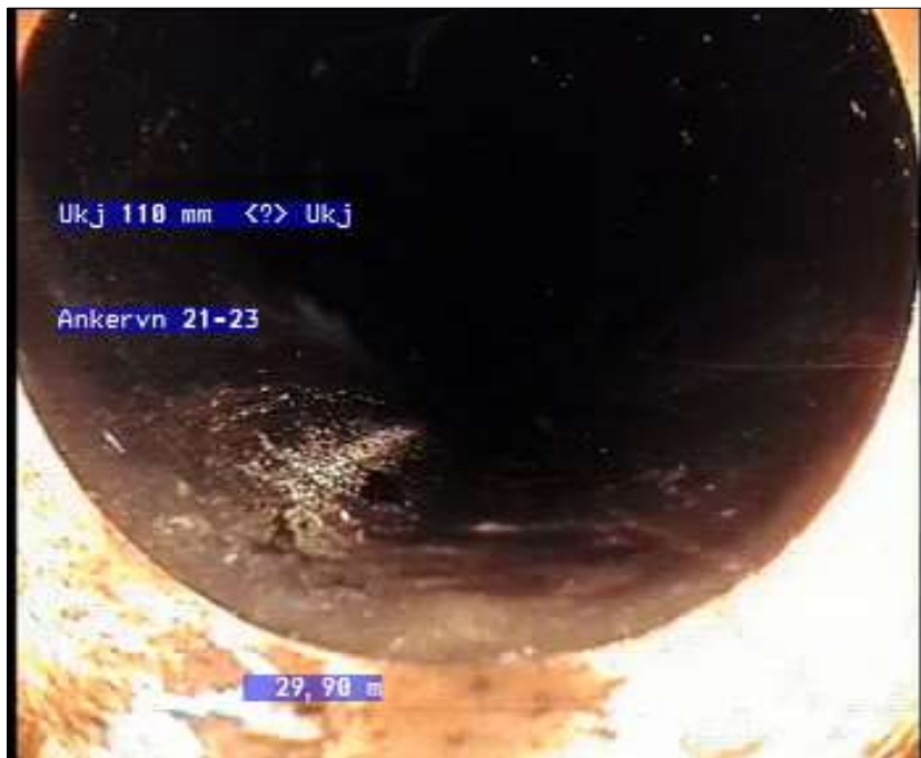
Foto: 5_1_13_11112014_054222_A.jpg 29,9m, Materialendring til Plast, svarte plastrør
