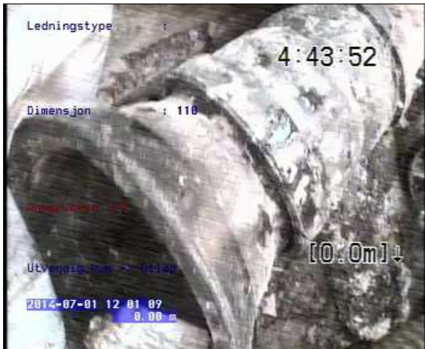
Foto: 3_1_1_10112014_052136_A.jpg 0m, Start inspeksjon -
