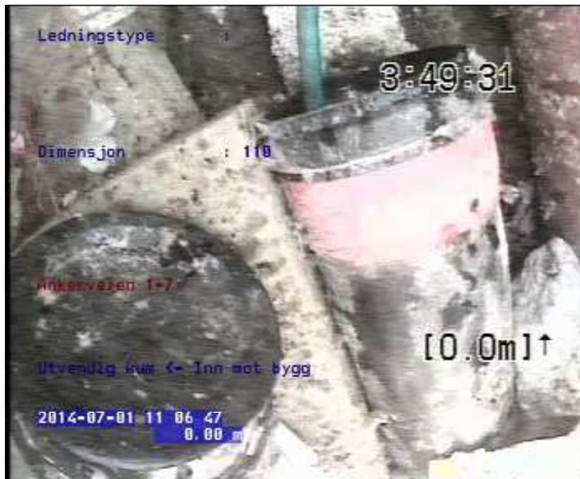
Foto: 2_1_1_10112014_050012_A.jpg 0m, Start inspeksjon -
